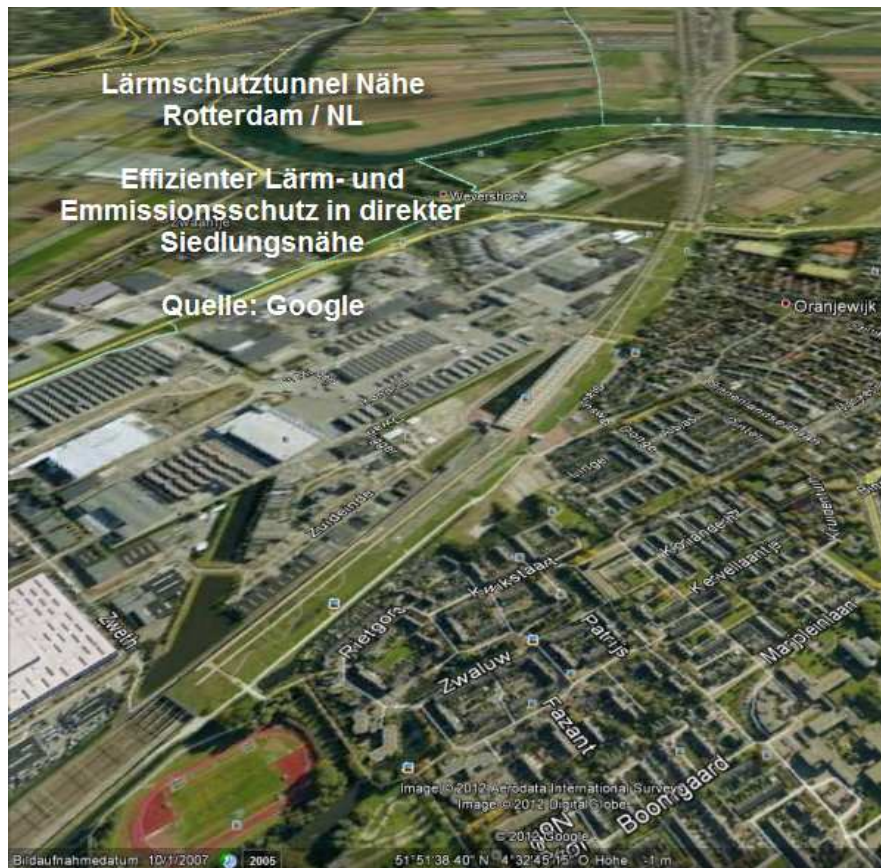
Bild 10: Vorbildlicher Lärmschutztunnel in gedeckelter Trogbauweise für den lärmintensiven, schienengebundenen Güterfernverkehr bei Rotterdam / Niederlande
