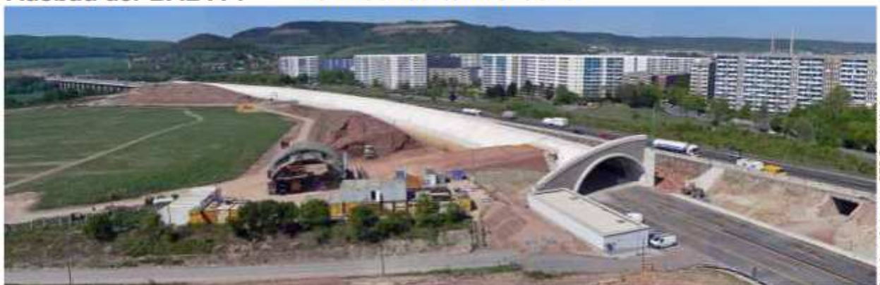
Ansicht Südröhre (Bauzustand)
